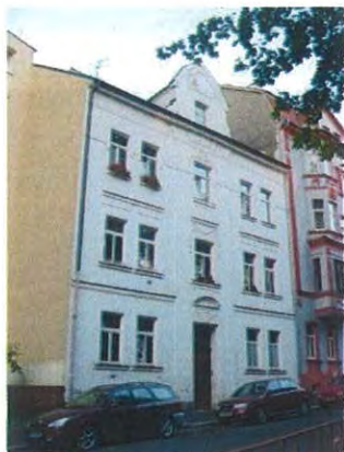
severozápadní pohled z Komenského ulice
