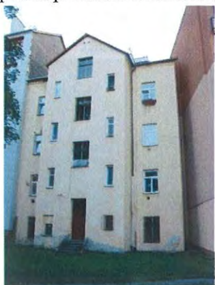
východní zadní pohled z dvorního traktu
